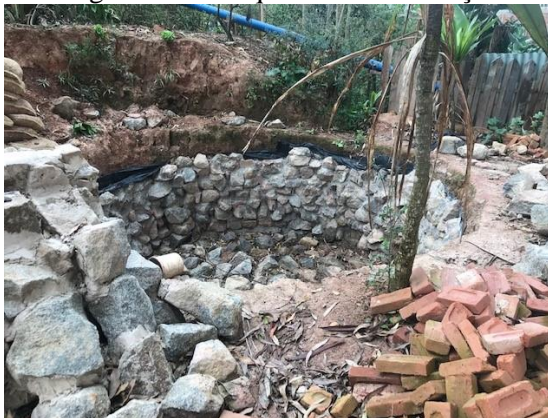
Figura 18 – Pesqueiro em construção
